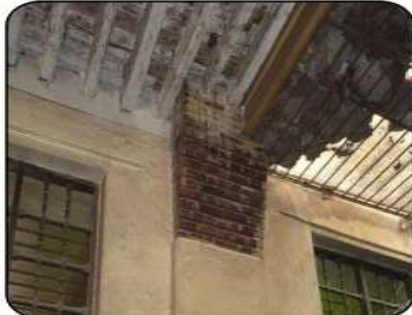
لوحة (١٥) كوابل من لطوب الأحمر بلصلة الرئيسية رقم (٣) بالدور الأرضي لمصنع الكسوة بالخرنفش (تصوير الباحث)
