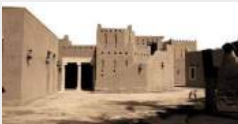
اختلف الطراز وأصبح مشابهة للمباني النجدية.
