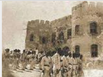
الطراز العثماني تبعاً للحقبة الزمنية التي بني فيها القصر.
