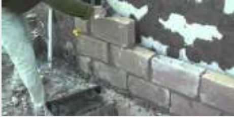
البناء بالطرق الحديثة باستخدام الآلات والطرق المنظمة.
