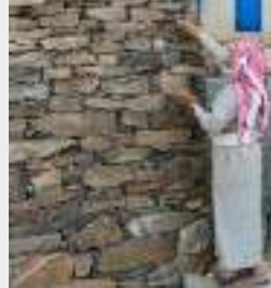
البناء بطريقة القديمة استخدام الحجارة والأيدي بطريقة عشوائية منظمة دون تدخل أي الآلات أو غيرها.
