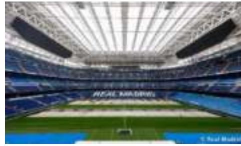
صورة توضح الأرضية المتحركة وعمليات انشاء السقف القابل للطي – ملعب سانتياغو برنابيو - المصدر: Real Madrid
